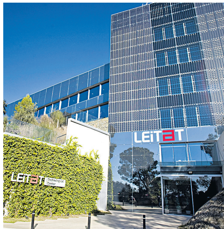
La seu central de Leitat està situada al nord de Terrassa / N. ARÓZTEGUI
